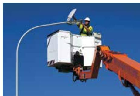
La sostituzione delle vecchie lampadine a scarica è importante.
