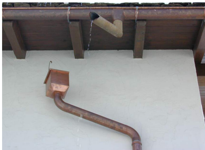
Fig. 9 : Système de descente amovible selon la saison. Source : C. U. Brunner, Zürich
